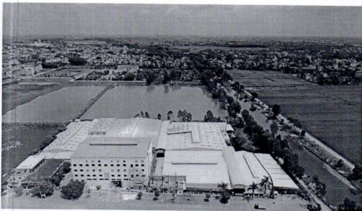
Nhà máy 1A, 1B
